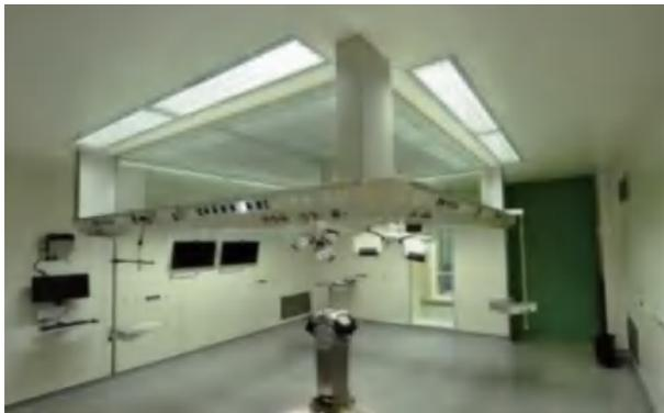
图2 手术室带高围挡送风装置
