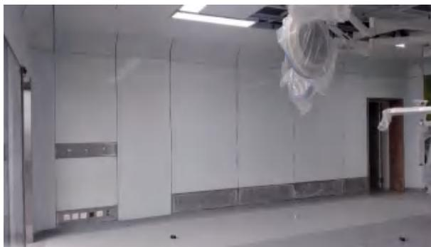
图 2 手术室玻璃隔断现场安装图
