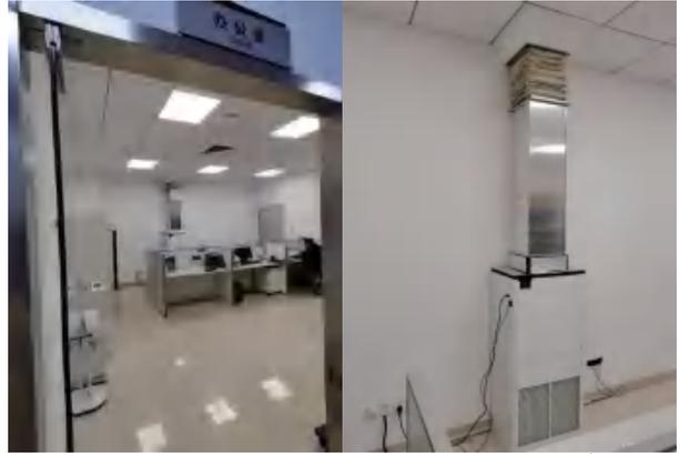
图 5 实地测试办公区 图 6 空调室内末端改造下回风气流净化机组
