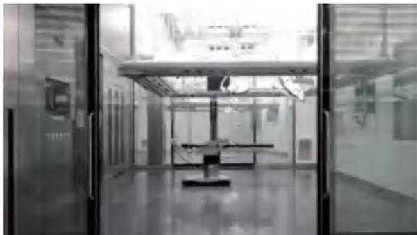
图 5 带落地移动玻璃隔断的通仓手术室
