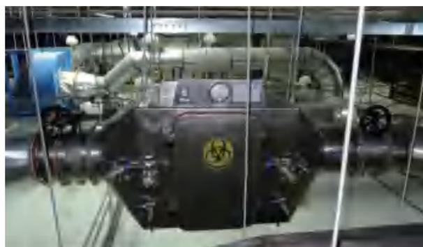
图 2 管道型排风高效过滤装置外观
